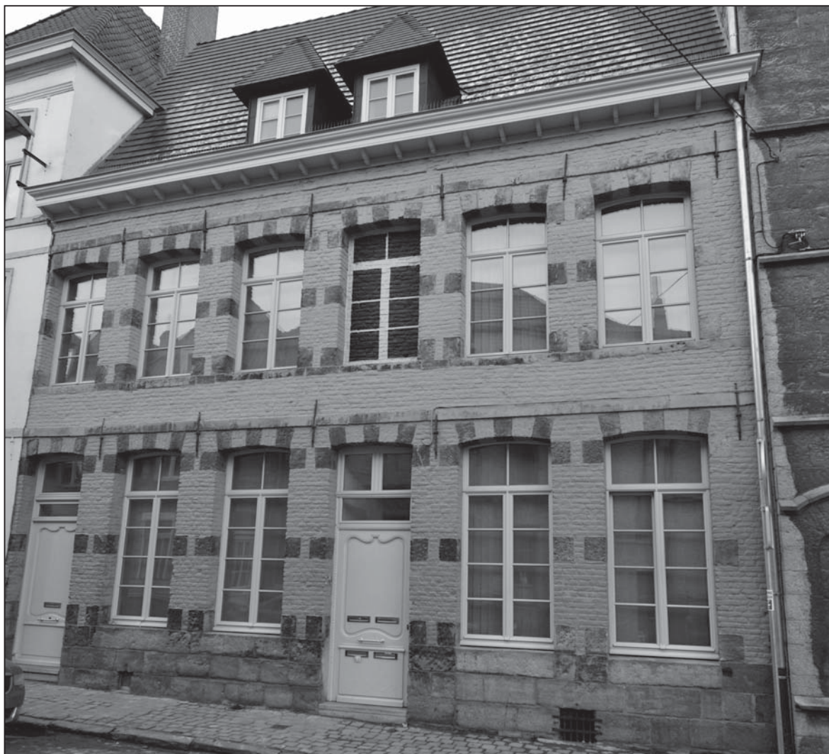
Rue Barre Saint-Brice, n°24 et 26.
